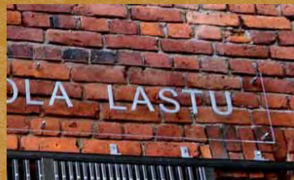
Alumiinikirjaimet, pinta raepuhallettu, maalaamaton, kirjaimet kiinnitettyinä kirkaaseen akryylipohjalevyyn, opasteen seinäkiinnitys kierretapeilla, korokeholkeilla ja hattumuttereilla Ravintola Lastu, Sibeliustalo, Lahti
