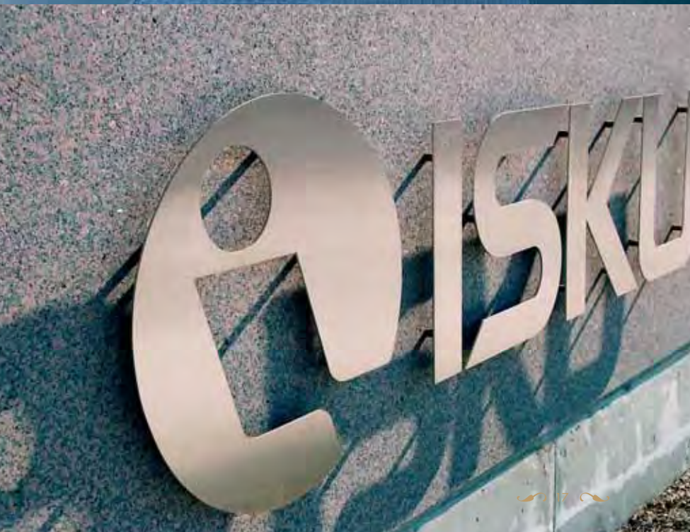
Alumiinikirjaimet, pinta raepuhallettu, maalaamaton, kirjaimet kiinnitettyinä kirkaaseen akryylipohjalevyyn, opasteen seinäkiinnitys kierretapeilla, korokeholkeilla ja hattumuttereilla Ravintola Lastu, Sibeliustalo, Lahti
