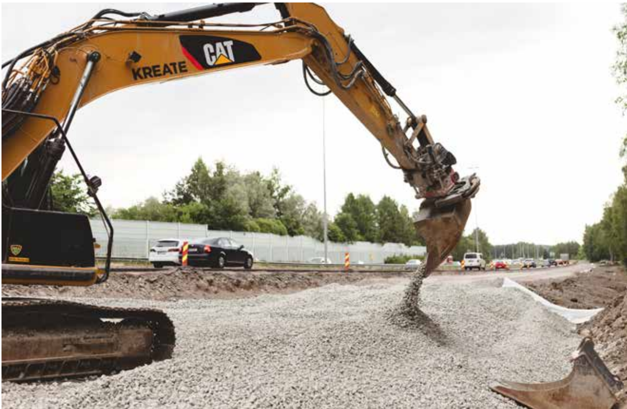
Kuva 5.1. Tien leventäminen vaahtolasimurskekevennyksen avulla.
