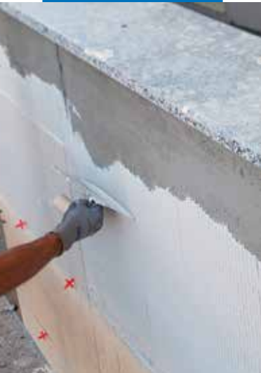
Laastin levitys julkisivulaatoituksessa
