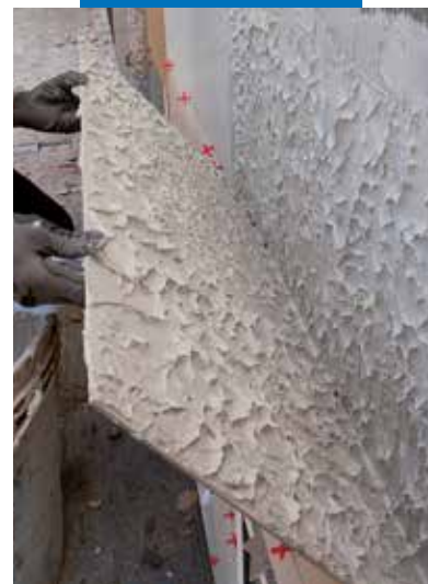
Laastin peittävyuden tarkastus ulkolaatoituksessa
