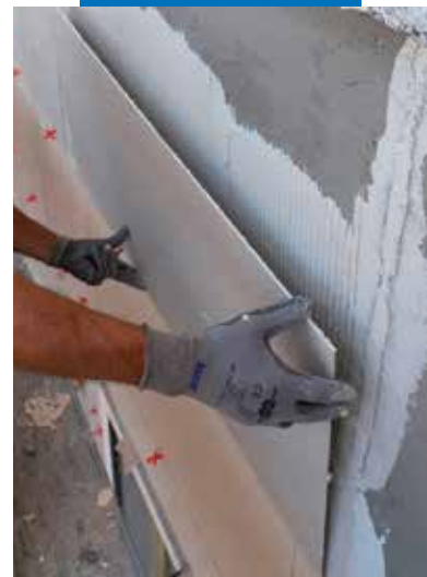
Ohuen porcellanatolaatan kiinnitys julkisivuun
