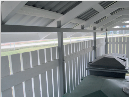
Rungon ja katon kiinnitys on tehty kestävästi vuosikymmeniä.
