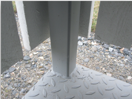
Tukevasti lattiaan hitsatut neliöprofiilitolpat.
