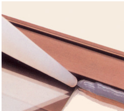
Ikkunan alumiinikarmin tiivistys
