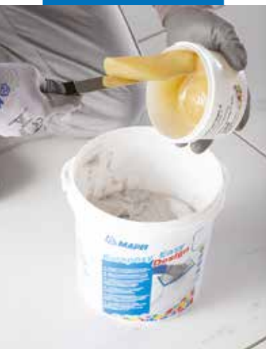
Kaada kovete (komponentti B) komponentin A astiaan
