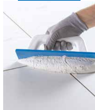
Levitä Kerapoxy Easy Design Mapei-lastalla
