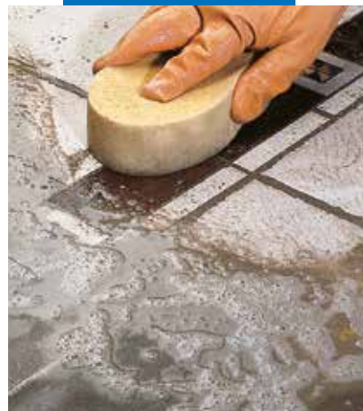
Keraamisten lattialaattojen ja puumosaikin viimeistely sienellä
