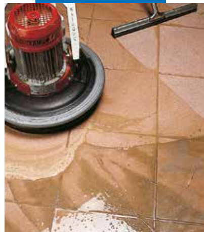
Posliinilaattalattian viimeistely lattiahoitokoneella tai kumilas-talla
