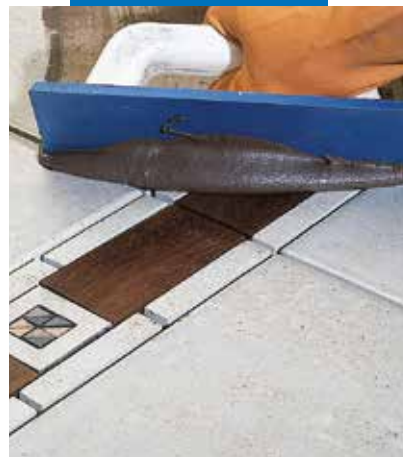
Keraamisten lattialaattojen ja puumosaikin saumaaminen hammaslastalla
