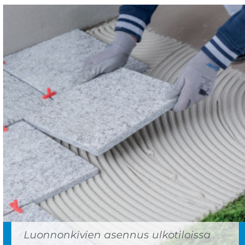
Isojen keraamisten laattojen kiinnittäminen
