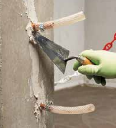
Halkeamien täyttämistä ennen injektointia
