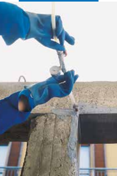
Pilarien korjausta Adesilex PG1:llä
