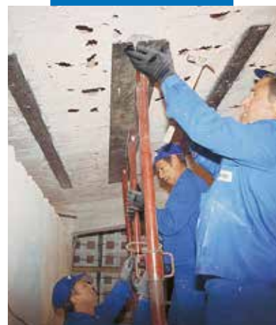
Teräsvahvikkeen asennus rakenteellisessa korjauksessa
