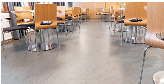
Sika® ComfortFloor® Marble FX on uusin PU-pinnoitemenetelmä Sika ComfortFloor®-valikoimassa. Runkomassa Sikafloor®-3000 FX:n uusi värjäysmenetelmä mahdollistaa lukemattomien erilaisten kuvioiden luomisen asennuksen aikana.
