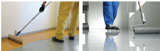
Sikafloor®-lattiapinnoitteet levitetään nestemäisenä.
