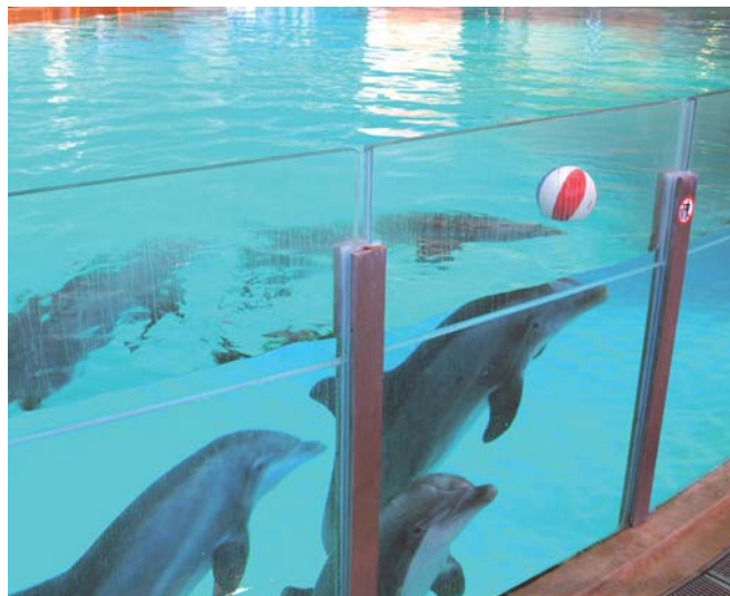
Särkänniemen Delfinaario, Tampere 2006. Karkaistut allaslasit 12+12+12 kirkas 1.52. Laminoidut karkaistut akvaariolasit 12+12+12+12 optiwhite-lasia, kirkas 1.52, suurin 3845 x 1756 mm.
