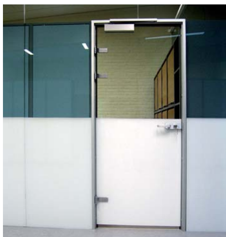
JT-lasiovi 4+4 karkaistu laminoitu, värikalvoilla, toimiston lasiseinällä. Ovessa on kolme saranaa, lukollinen painike, ovipumppu ja alumiinikarmi.
