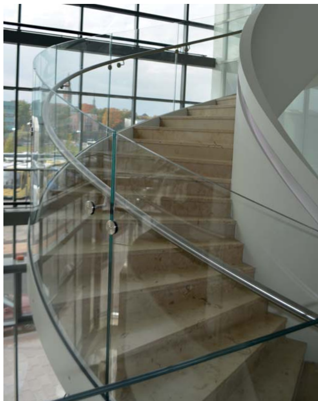
Taivutetut karkaistut ja laminoidut optiwhite-kaidelasit 8ow(h)+8ow(h) kirkas, 2013.
