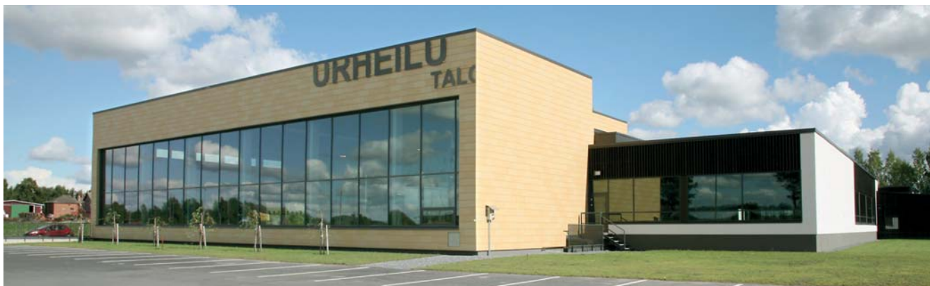
Euran urheilutalo, 2013. 3K-eristyslasi 6I-T10-5-T10-(4+0,76+4), ulkolasi Ipasol Natura 67/34, sisälasi laminoitu 4+4. Kuva Mari Aarikka.
