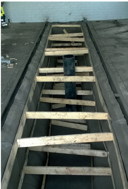
Hiekanerotusaltaan tiivistyskalvon suojaus
