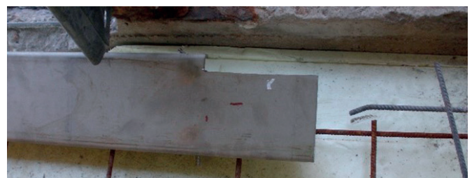
Kuva 3. Kynnyn päiden leikkaus tarvittaessa oikeaa asemointia varten oven tiivisteeseen nähden.
