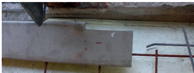
Bild 3. Skärning av tröskeln ändra för korrekt placering i förhållande till dörrtätningen.
