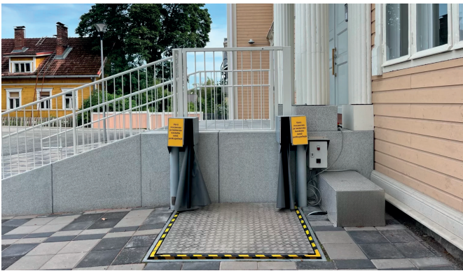
Innostin®-invanostin, nostokorkeus 950 mm, Kaarilan koulu, Hyhkyn koulutalo, Tampere.
