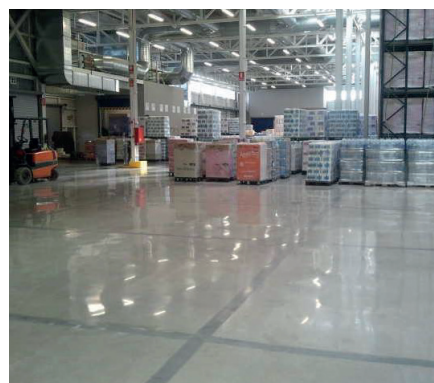
RetroPlate-betonilattian kiilloaste voidaan määrittellä mattapintaisesta peilikiiltäväksi asti.
