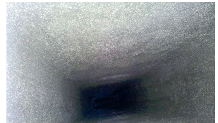
Hormi massauksen jälkeen
