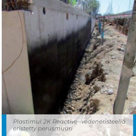
Veden valuminen kalvon pinnalla heti levittämisen jälkeen on täysin normaalia
