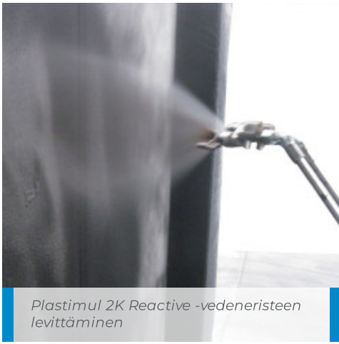
Veden valuminen kalvon pinnalla heti levittämisen jälkeen on täysin normaalia
