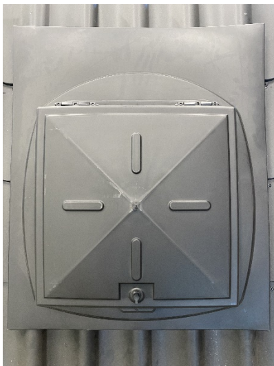
Kuva 7. Kattoluukku asennettuna
