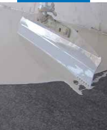
Mapefloor PU 460 N:n levitys
