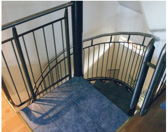
Askelmat ja taso päällystetty klinkkereillä
