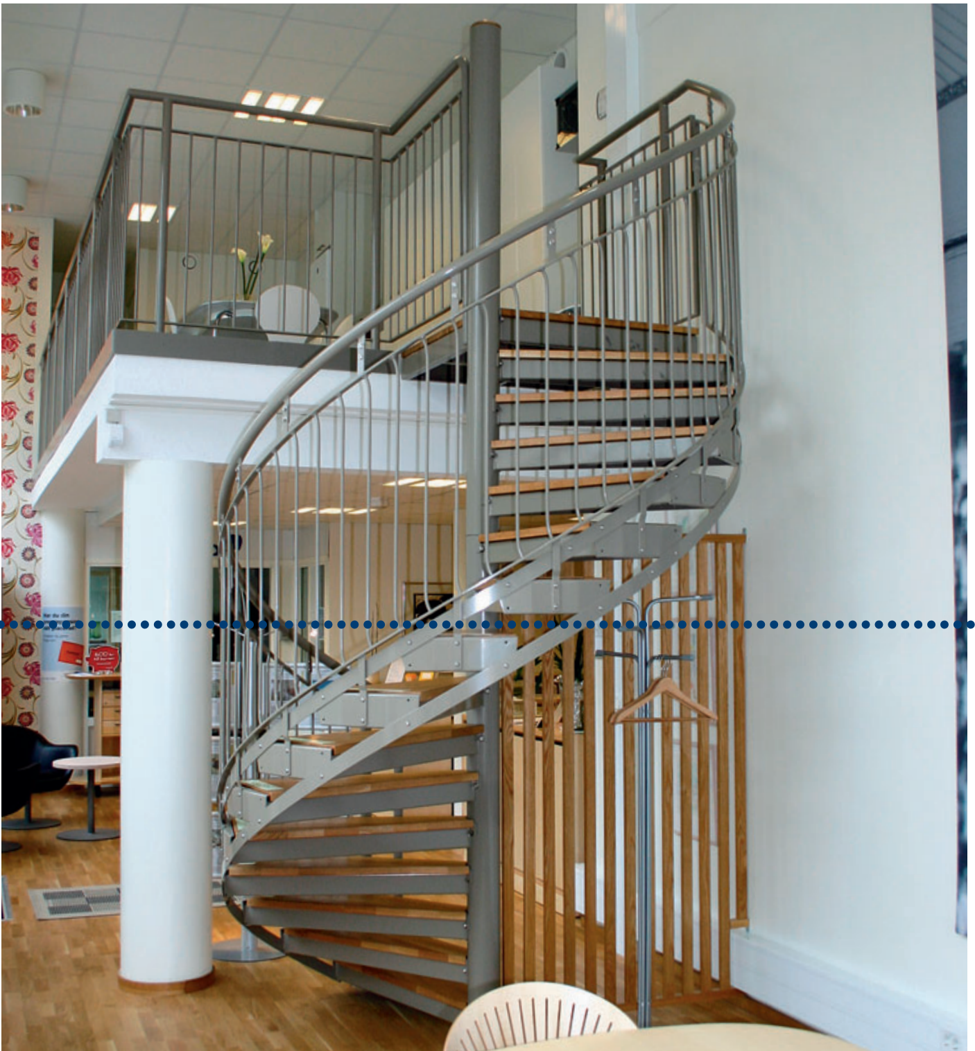
Harmaaksi maalattu porras jossa puiset askelmat ja käsijohteena teräspotki.
