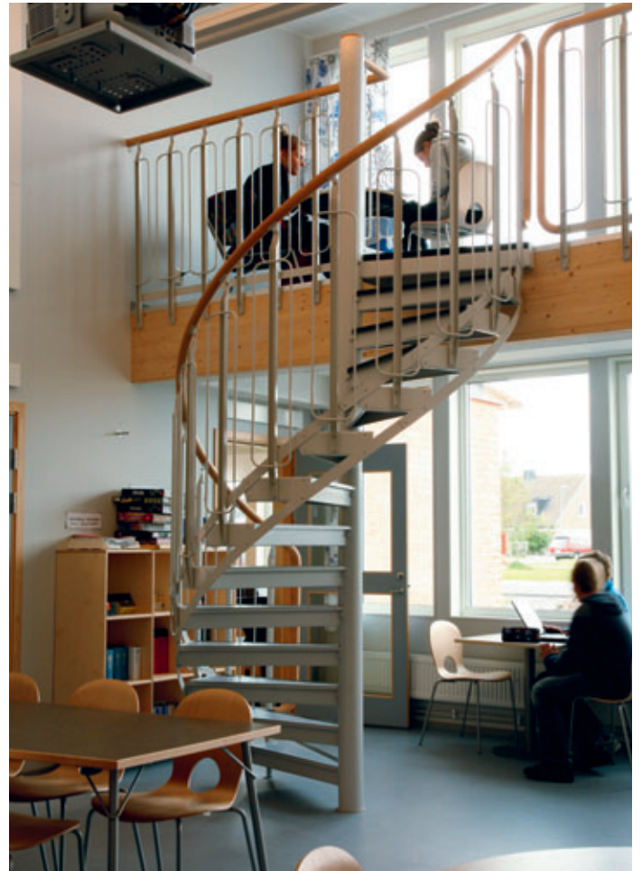
Puinen käsijohde ja matolla päällystetyt levyaskelmat
