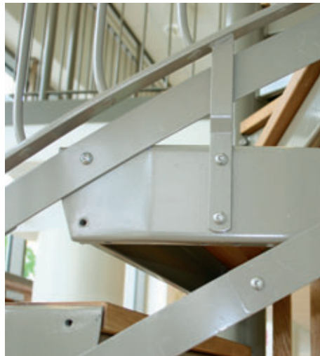
Harmaaksi maalattu porras jossa puiset askelmat ja käsijohteena teräspotki.
