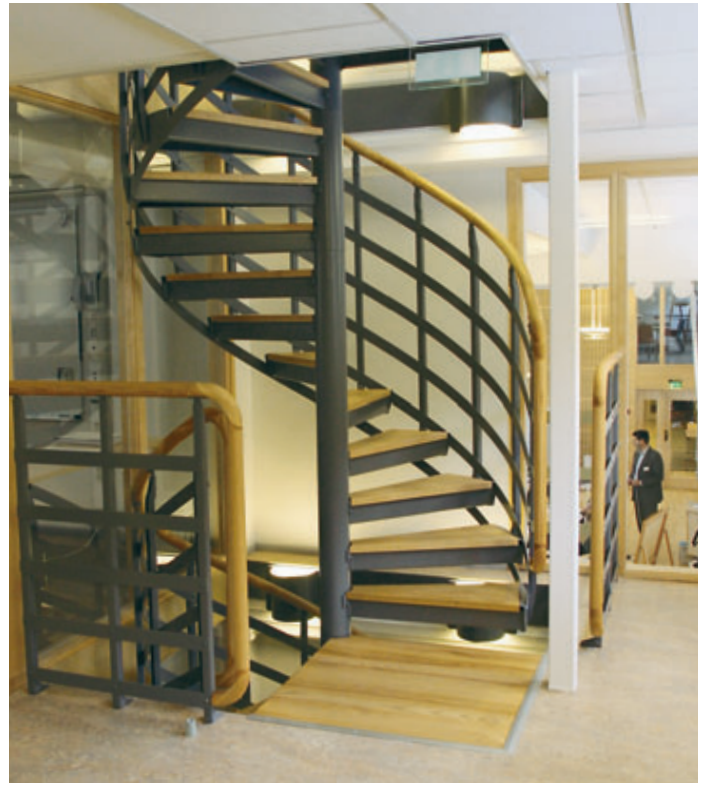
Kaiteessa neljä välijohteetta. Askelmat ja käsijohde öljyttyä saarnia
