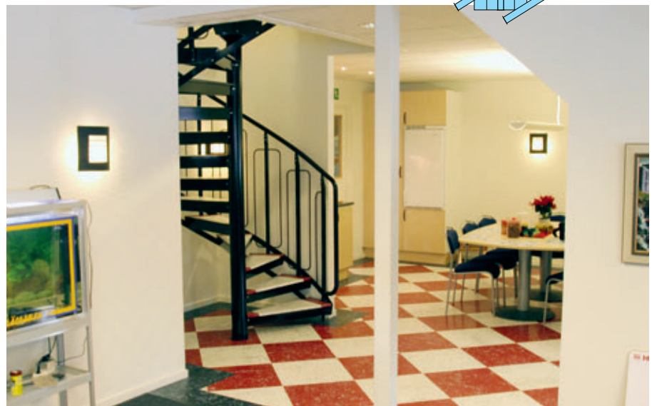
Matolla päällystetyt- levyaskelmat. ▶
