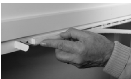
THERMOMAX VENTTIILIN SUODATTIMEN VAIHTO
