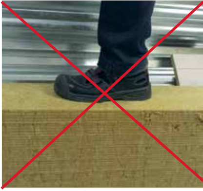
Kuva 4. Paljaan lamellin päälle ei saa astua!
