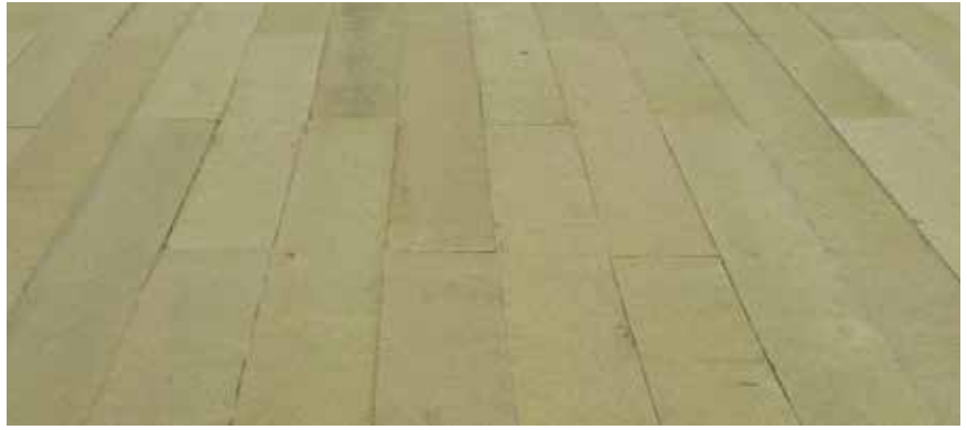
Kuva 5. Oikeaoppisessa asennuksessa lamellit eivät muodosta ristikuvioita.
