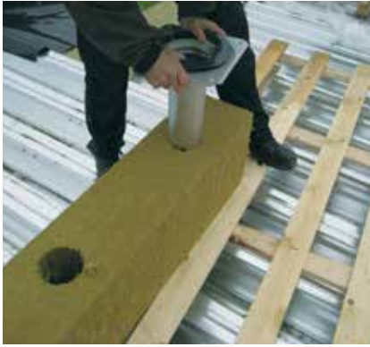
Kuva 8. Kattokaivo työnnetään varovasti lamellista läpi, leikkautuva villa poistetaan ja läpivienti on valmis. Ylimääräistä tiivistystä ei välttämättä vaadita. Suurin osa läpivienneistä voidaan tehdä tällä tavalla.
