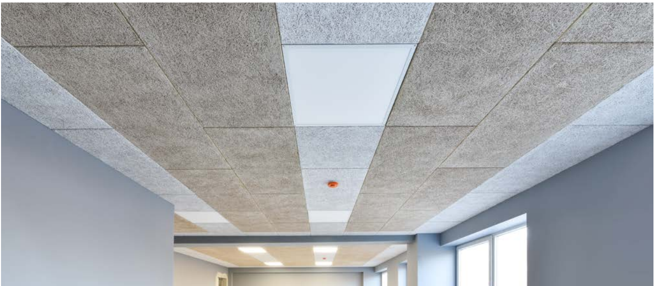
T-profiilit, P0G-reunaprofiili, 25 mm:n CEWOOD-akustiikkalevy.
