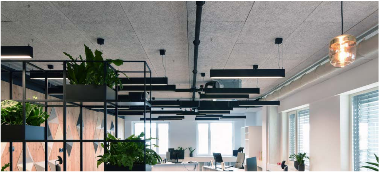
Puulistat, P0-reunaprofiili, 25 mm:n CEWOOD-akustiikkalevy.
