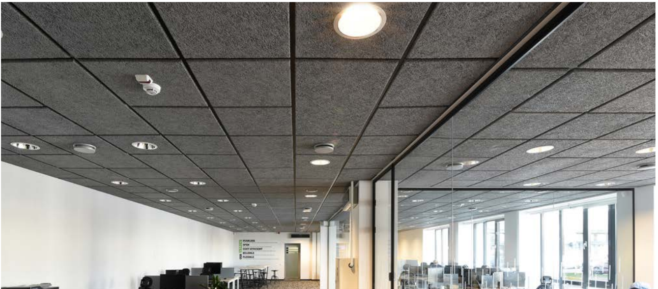
T-profiilit, P0G-reunaprofiili, 25 mm:n CEWOOD-akustiikkalevy.
