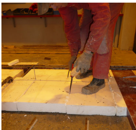
Kuva 21. Kovien eristelevyjen välisten rakojen tiivistäminen.
