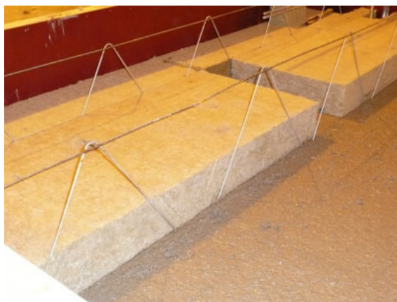
Kuva 21. Kovien eristelevyjen välisten rakojen tiivistäminen.
