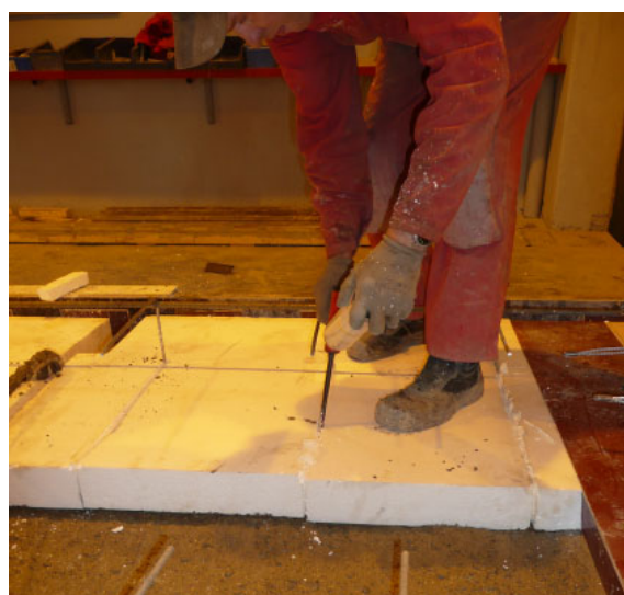
Kuva 21. Kovien eristelevyjen välisten rakojen tiivistäminen.
