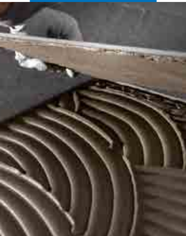
Ohuen porcellanato-laatan kiinnitys lattiaan
