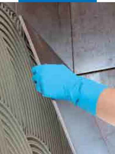
Isokokoisten laattojen kiinnitys seinään
