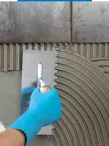
Ultralite S1-laastin levitys seinälle hammastetulla laastikammalla
