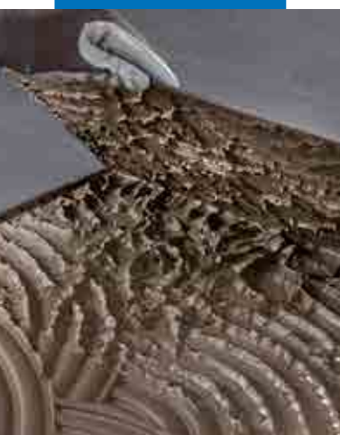
Ohuen porcellanato-laatan kiinnityslaastikerroksen tarkastus
