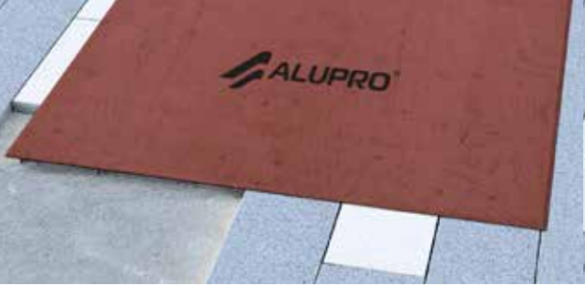
3. Asennuskaukalo suojataan kansilevyllä muun rakentamisen ajaksi.
