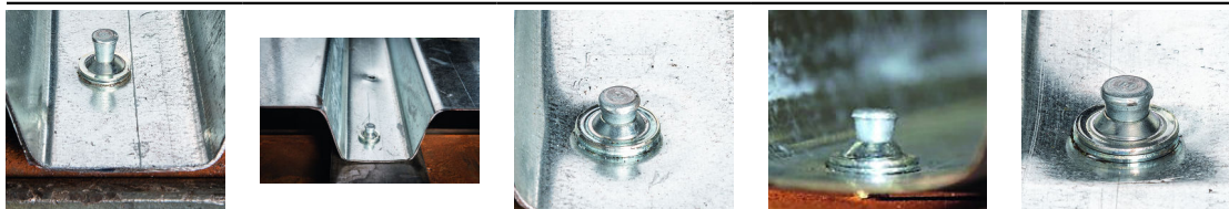
Nadmierne wystawianie gwoździa Wystawianie gwoździa jest prawidłowe Zbyt małe wystawianie gwoździa Szczelina między profilem poszycia a belką Nie trafiono w belkę
