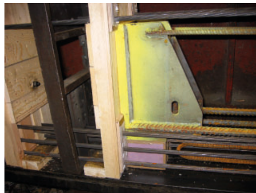
Kuva 12 Esimerkki lisäraudoituksesta ja PC-palkkikengän kiinnityksestä ennen valua
