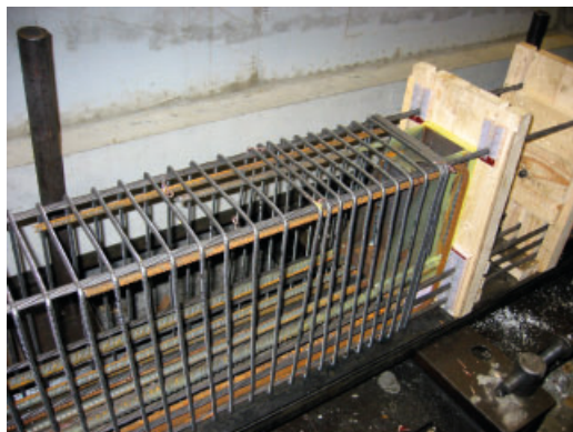
Kuva 12 Esimerkki lisäraudoituksesta ja PC-palkkikengän kiinnityksestä ennen valua
