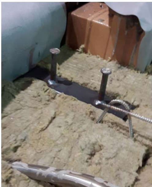
Kuva 18. KAPU® asennus sandwich-elementtiin.
