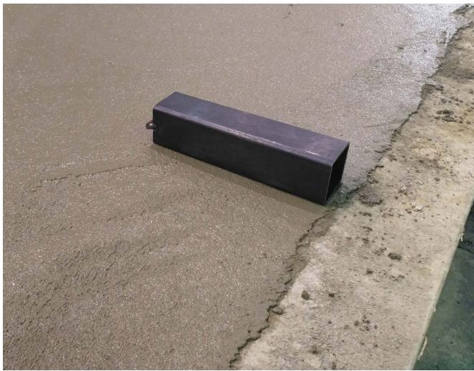
Kuva 16. KAPU® asennettuna elementin ulkopintaan.
