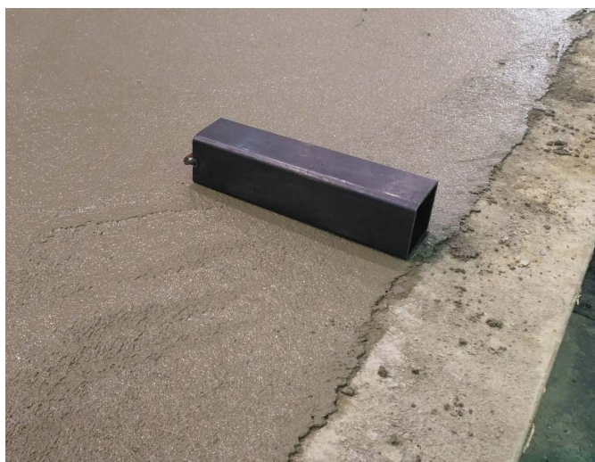
Kuva 16. KAPU® asennettuna elementin ulkopintaan.
