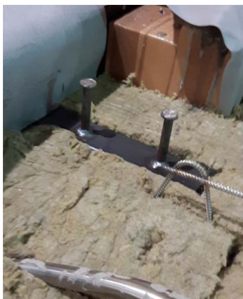
Kuva 18. KAPU® asennus sandwich-elementtiin.
