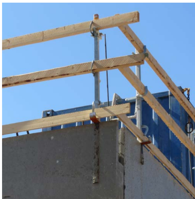
Kuva 17. KAPU® upotettuna elementtiin.
