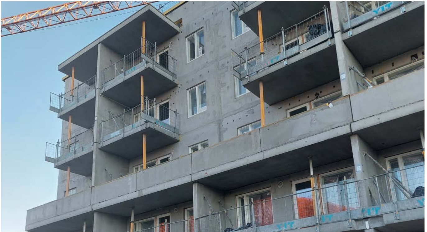
Kuva 1. Liikuntasauamalla jaetut parvekelaatat.
