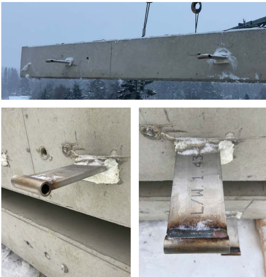
Kuva 13. Parvekelaatta, jossa PS-parvekesaranan osat B.
