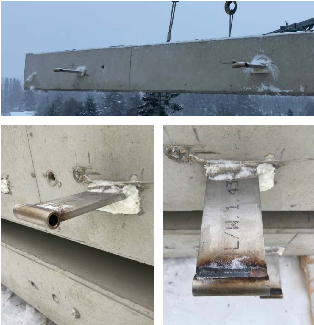
Kuva 13. Parvekelaatta, jossa PS-parvekesaranan osat B.
