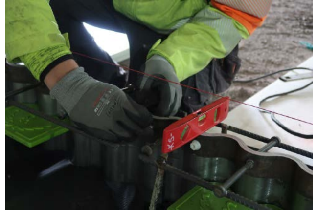
WAVEJOINT® voidaan tukea asennuspaloilla
