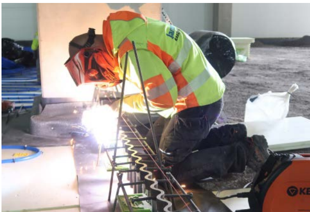
Asennustappien hitsaaminen kiinni WAVEJOINT®-liikuntasaumaan
