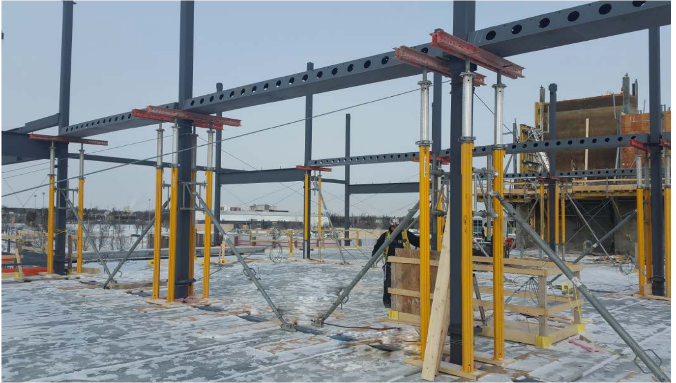
Kuva 6. DELTABEAM®-liittopalkkien suositeltava tuentatapa.
