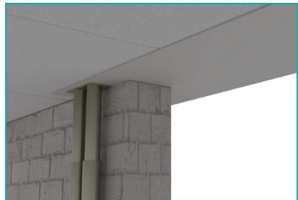
Palkin pään tuenta seinän päässä
