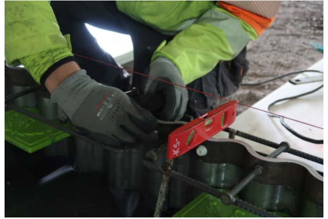
WAVEJOINT® voidaan tukea asennuspaloilla
