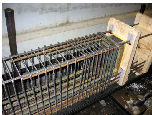
Kuva 16. Esimerkki lisäraudoituksesta ja PC-palkkikengän kiinnityksestä ennen valua.
