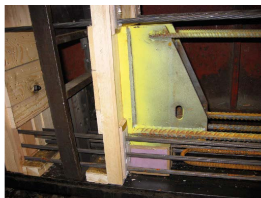
Kuva 16. Esimerkki lisäraudoituksesta ja PC-palkkikengän kiinnityksestä ennen valua.
