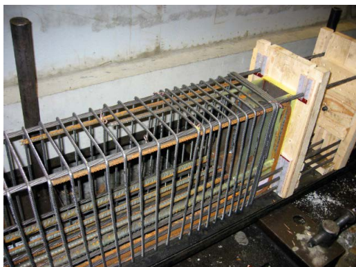
Kuva 16. Esimerkki lisäraudoituksesta ja PC-palkkikengän kiinnityksestä ennen valua.
