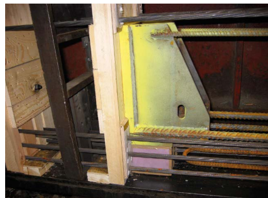
Kuva 16. Esimerkki lisäraudoituksesta ja PC-palkkikengän kiinnityksestä ennen valua.
