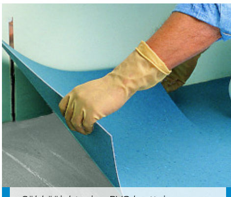
Sähköjohtavien PVC-laattojen asentaminen Ultrabond Eco V4 SP Conductivella
