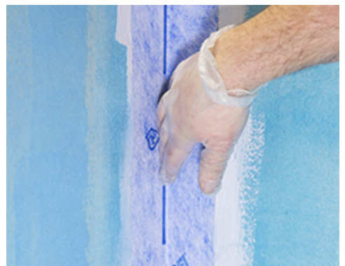
Mapei ST -vahvikenauhan asennus Mapegum WPS:ää käyttäen, seinä
