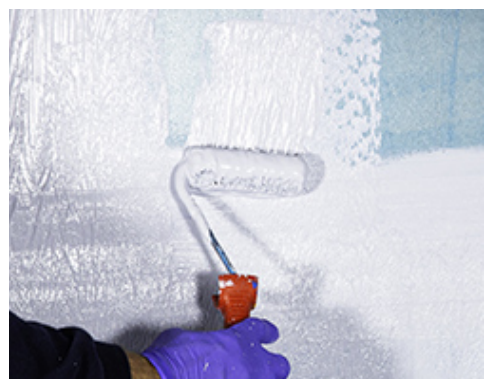
Mapegum WPS -vedeneristettä levitetään telalla
