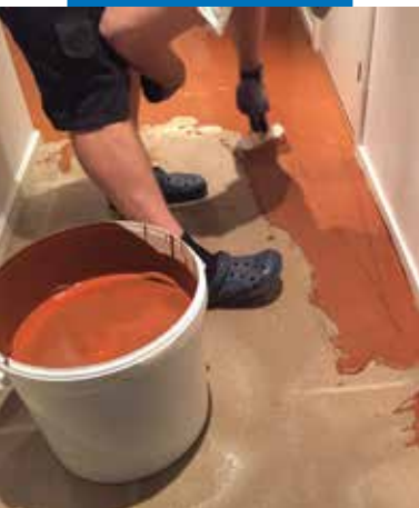
Levitä Mapefloor PU 462 -pinnoite tasaiseksi hammaslastalla.
