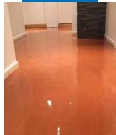
Mapefloor PU 462 lattiassa.
