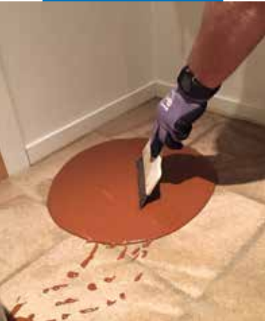
Mapefloor PU 462 -pinnoitteen levitys
