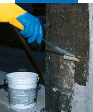
Toisen MapeWrap Primer 1 -kerroksen levitys
