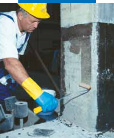
Ensimmäisen MapeWrap Primer 1 -kerroksen levitys
