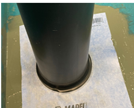
Mapeguard PC -läpivientikappaleen asennus käytettäessä Mapeguard WP 2K Membranea.
