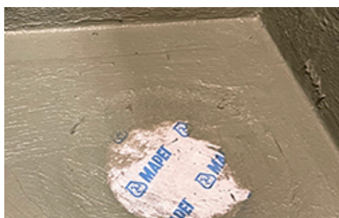
Mapeband B DC:tä käytetään lattiakaivoliittymien tiivistämiseen. Mapeguard WP 2K Membrane levitetään kaivokappaleen fleece-pinnalle ennen kiristysrenkaan asentamista.
