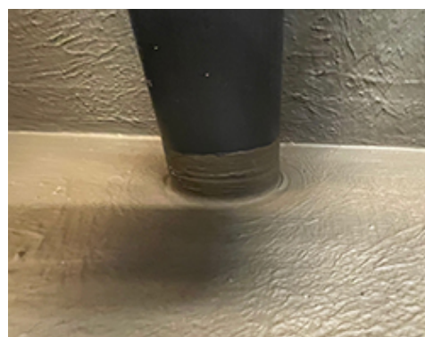
Mapeguard PC -läpivientikappale, jonka päälle on levitetty Mapeguard WP 2K Membrane.
