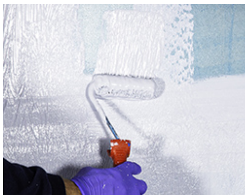
Mapegum WPS -vedeneristettä levitetään telalla
