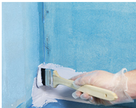
Mapei IC/EC -kulmakappaleen asennus Mapegum WPS -vedeneristettä käyttäen
