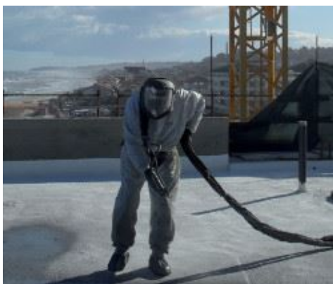
Purtop 400 M, levitys Triblock P - pohjusteen päällä
