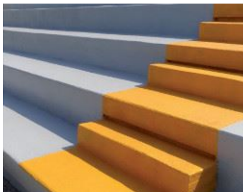
Terassikatsomo, vesieristeenä Purtop 400 M ja pinnoitteena Mapecoat PU 20 N
