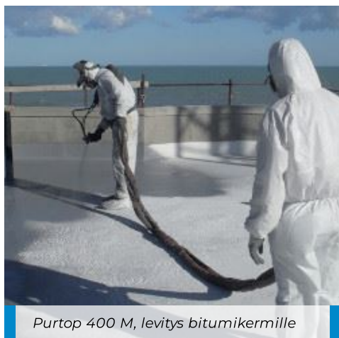
Terassikatsomo, vesieristeenä Purtop 400 M ja pinnoitteena Mapecoat PU 20 N
