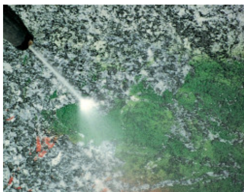
WallGard Graffiti Barrierilla käsiteltyä graniittipintaa pestään painepesurilla
