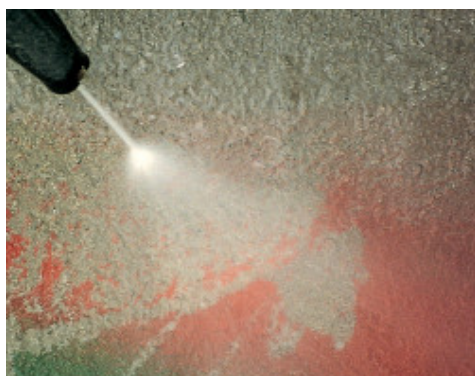
WallGard Graffiti Barrierilla käsiteltyä betonipintaa pestään painepesurilla
