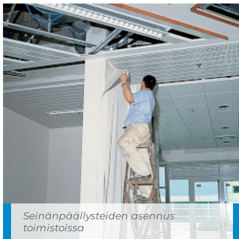
Seinänpäällysteiden asentaminen Adesilex MT32:lla
