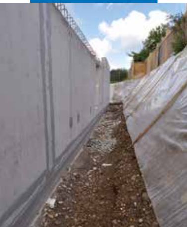
Tukiseinämiä rakennesaumojen tiivistäminen
